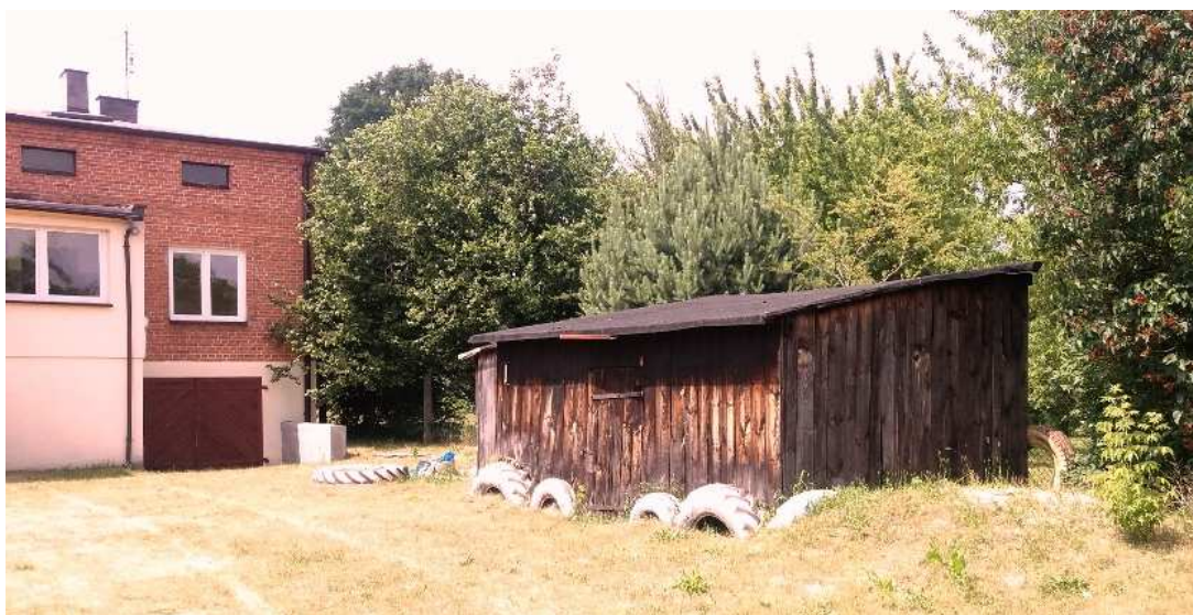
Budynek gospodarczy przeznaczony do rozbiórki.
